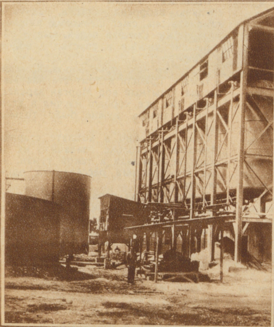
Американское общество „Стандарт-Ойл“, имеющее концессию в Батуме, недавно закончило постройку большого керосиноочистительного завода. На этом заводе керосин подвергается усиленной ректификации с тем, чтобы при перевозке через тропики он не подвергался порче. На снимке—одна из построек нового завода.
