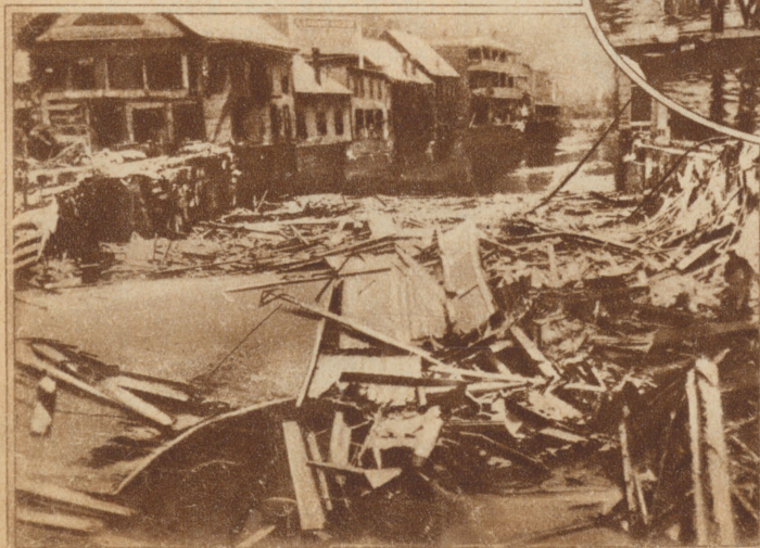
Разрушения в городе Монпелье в штате Вермонт
